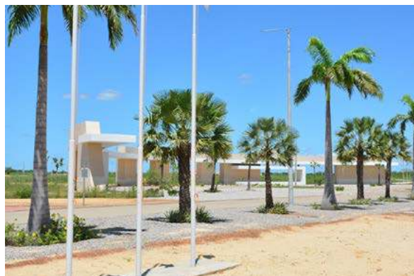
> Parte do projeto já está concluída.
